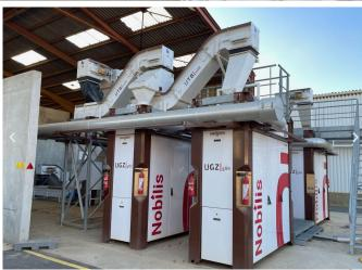
Dans le cadre de son activité, un producteur a besoin d'un réseau de convoyeurs qui récupère les copeaux de bois à partir d'un silo et les transporte jusqu'aux machines de gazéification.
